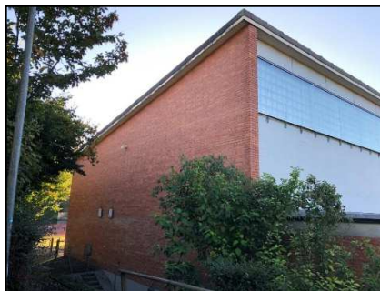
Foto 2: Ansicht Nordfassade mit massiver Mauerwerkswand
