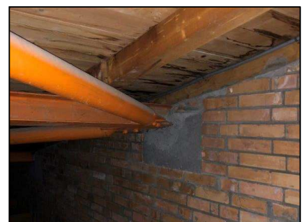
Foto 6: Ansicht Endauflager Windverband, sauber einbetoniert
