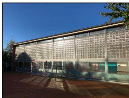
Foto 4: Ansicht Ostfassade als Stahlbau mit Glasbausteinen
