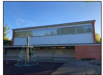
Foto 3: Ansicht Westfassade mit Lichtband
