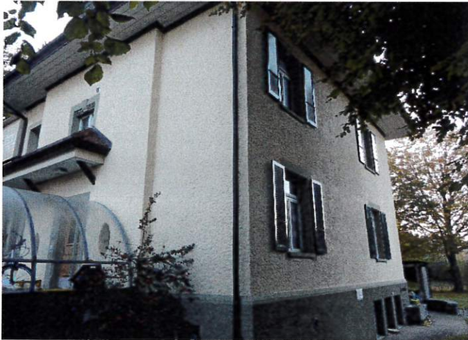
Südwest- und Nordwestfassade
