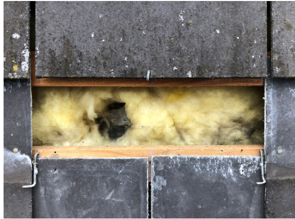
Abb. 32: Bestehende Dämmung (Sondage Fassade)
