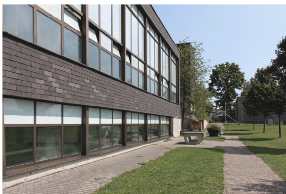
Abb. 7: Fassade Turn- und Schwimmhalle
