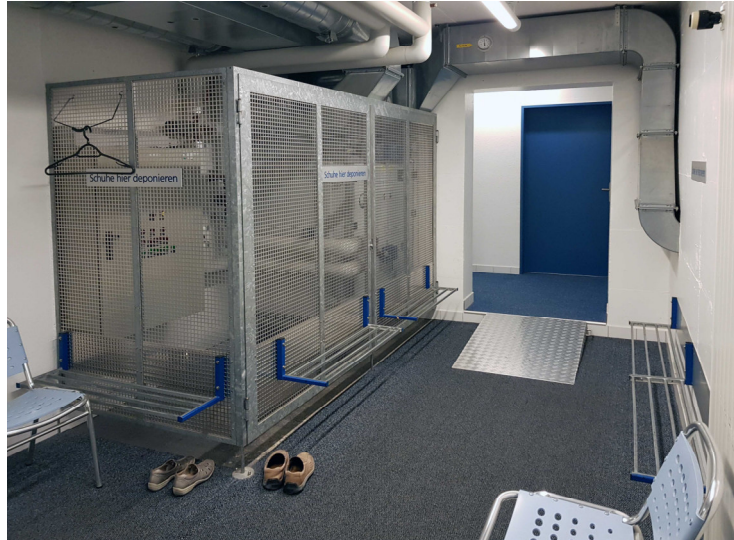
Abb. 59: Lüftungsanlage Schwimmbad im 1. UG
