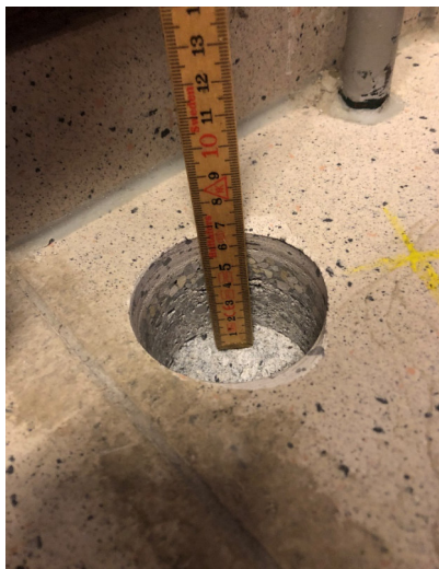
Abb. 37: Sondage Fliesenboden (WC)
