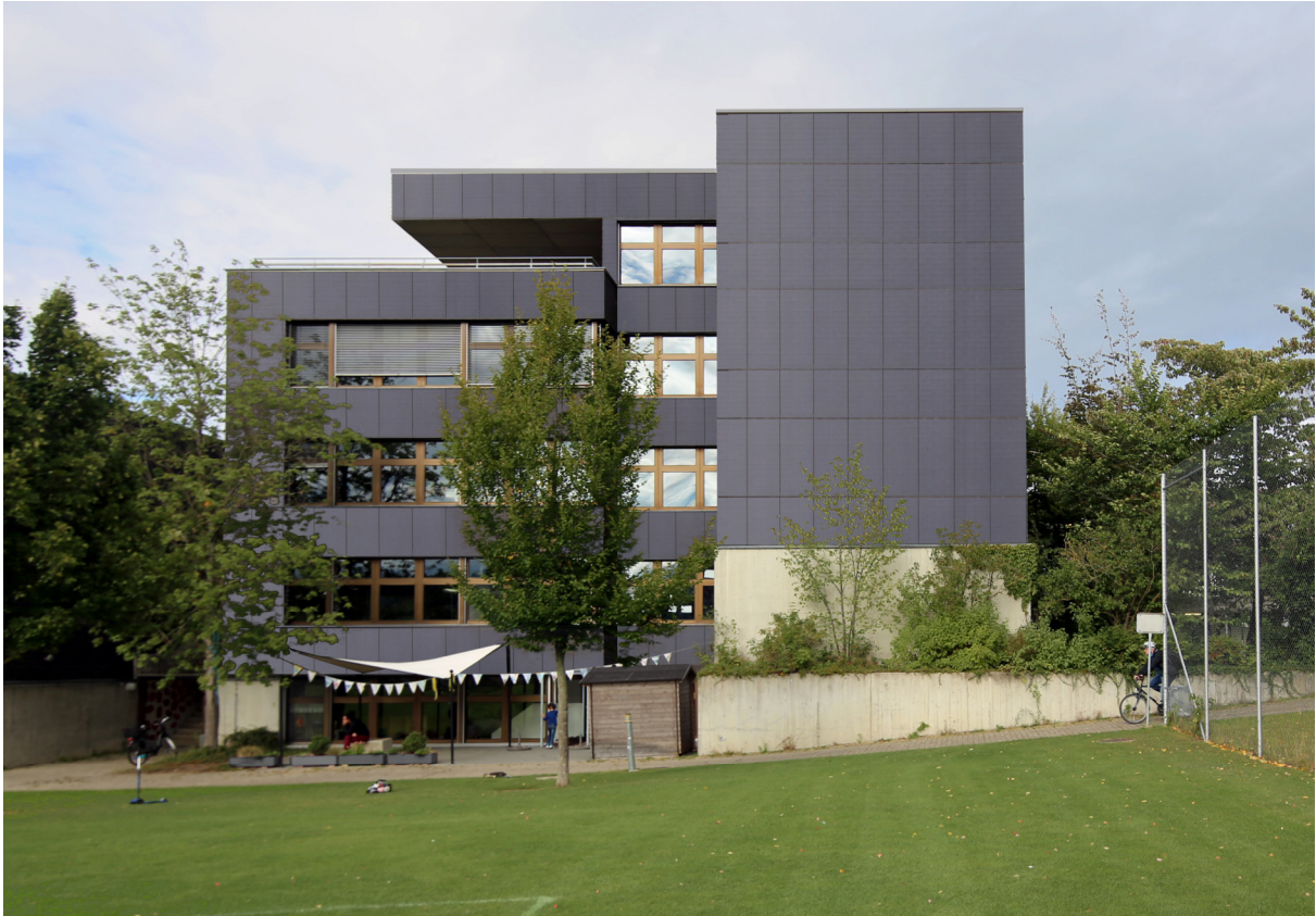
Abb. 30: Visualisierung Gebäudeansicht Südwest mit PV-Modulen
