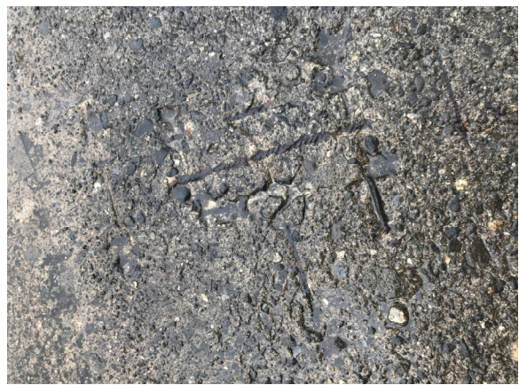
Abb. 34: Das Pausendach ist als Sichtbetondach ausgeführt. Durch die Bewitterung sind die Bewehrungsstäbe teilweise freigelegt und korrodiert.
