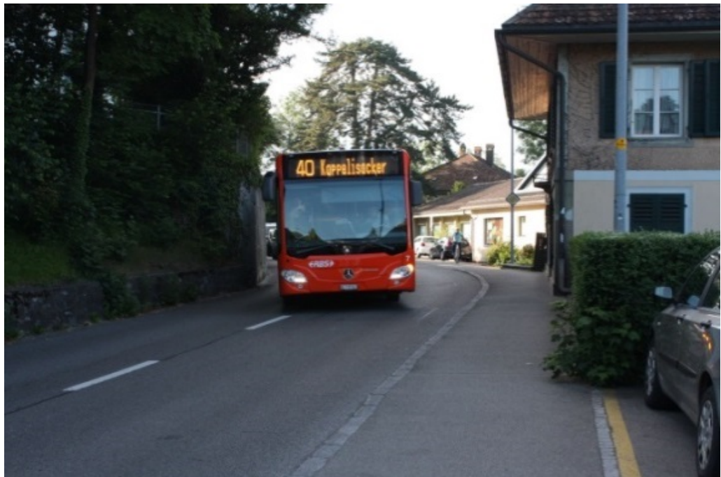
Abbildung 8: Hauptstrasse mit schwerwiegenden Defiziten (Thunstr., Schlossmauer)
